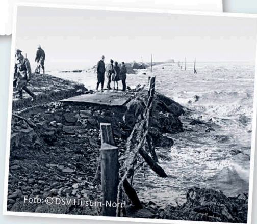
Deichbruchstelle am Dockkoog nach der Flut 1962.
